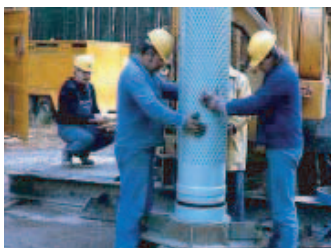
Filterrohre werden eingebaut
